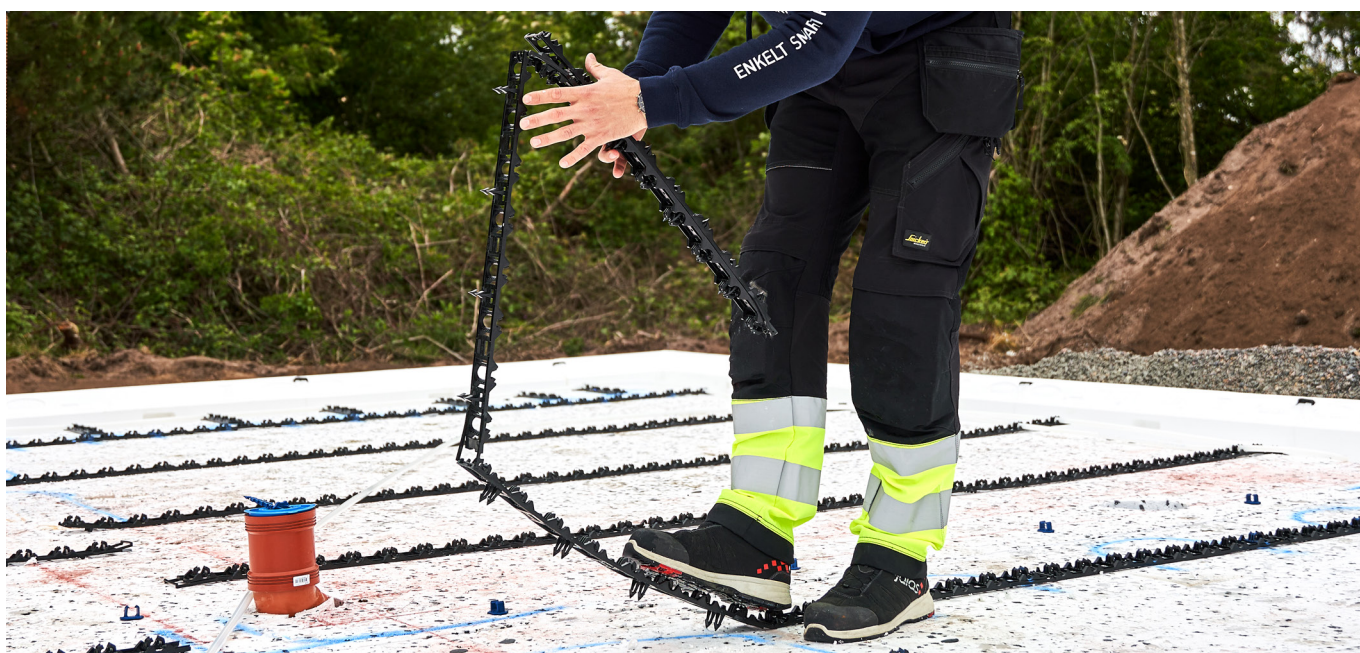
VVS-montøren vikler ut og legger ned skinnen på EPS-isoleringen.
