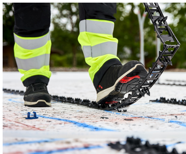
LK Leggeskinne Combi 16/20 på EPS-isolering.
